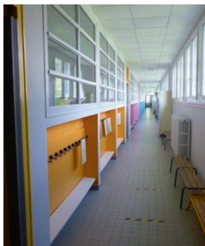
Réhabilitation complète de la maternelle Pézole
